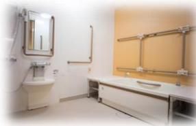
【ユニット内浴室】
